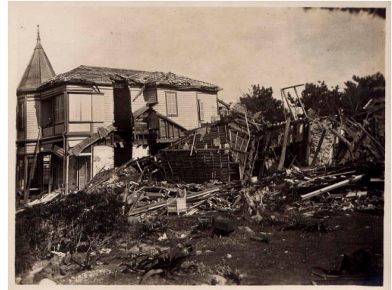
材木座モリソン屋敷付近流失
