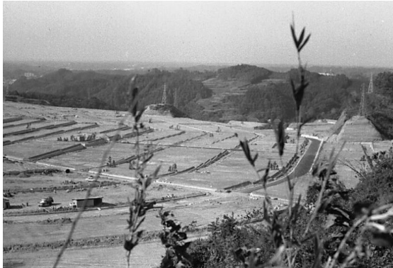
宅地造成 昭和40年10月3日撮影 広大な今泉信販団地の宅地造成現場。 この頃より、鎌倉での大規模な宅地造成が始まった。
