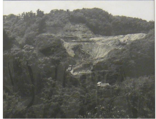
宅地造成 昭和40年夏撮影 浄明寺釈迦堂ヶ谷の宅造工事現場。崩されかけたやぐら群が遠望される。宝戒寺二世普川国師入定窟の伝承のあるやぐらを中心に約50穴のやぐら群があった。
