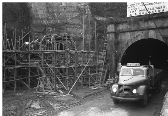
大仏坂トンネル 昭和32年撮影 明治末に開通した大仏坂トンネルの脇に、もう一本のトンネル工事が進んでいる。
