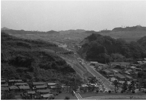
宅地造成 昭和44年5月15日撮影 現在の鎌倉逗子ハイランドの宅造工事。 明石橋付近から逗子・久木方向を望む。
