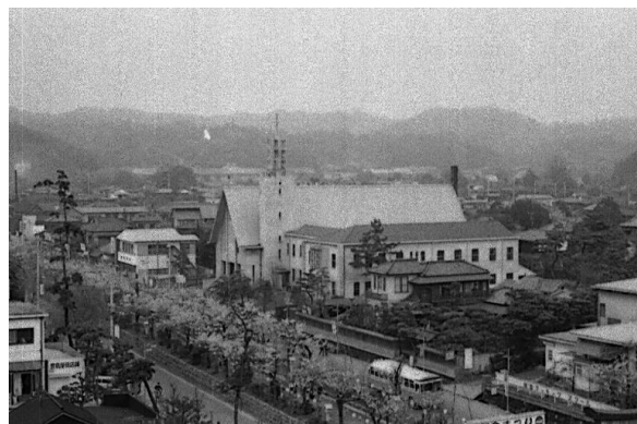
消防署から見た段葛 昭和39年4月11日撮影 当時の消防署は現在のスーパー・ユニオンの場所にあった。中央に見えるのは雪ノ下カトリック教会。
