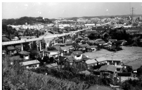
大船の町 昭和44年10月1日撮影 水道山から大船観音を望む。湘南モノレールはまだ工事中。昭和45年3月に大船ー西鎌倉間が全国初の通勤用モノレールとして開通した。
