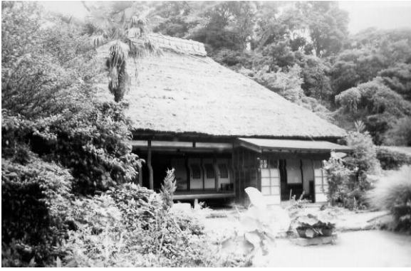
帰源院建物解体前
