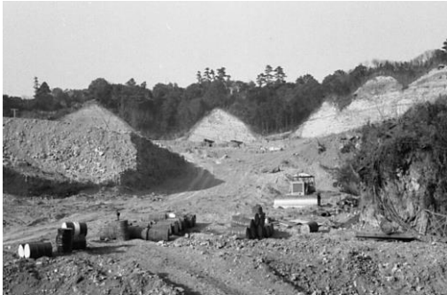
宅地造成 昭和41年2月12日撮影 胡桃谷における宅地造成現場。 無惨に削り取られた山肌が痛々しい。
