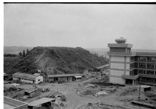
造成工事 昭和38年8月6日撮影 玉縄城址。建設中の建物は現在の清泉女学院。 建物の左側の丘は玉縄城諏訪壇で、これは辛 うじて今も校内に残されている。
