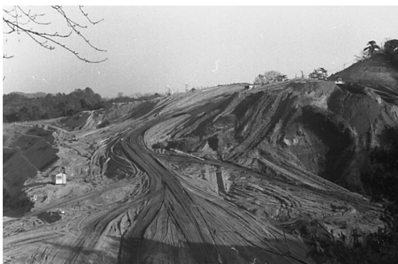
宅地造成 昭和45年11月24日撮影 冬空の下、縦横に広がってゆくトラクターの軌跡。笛田地区にて。
