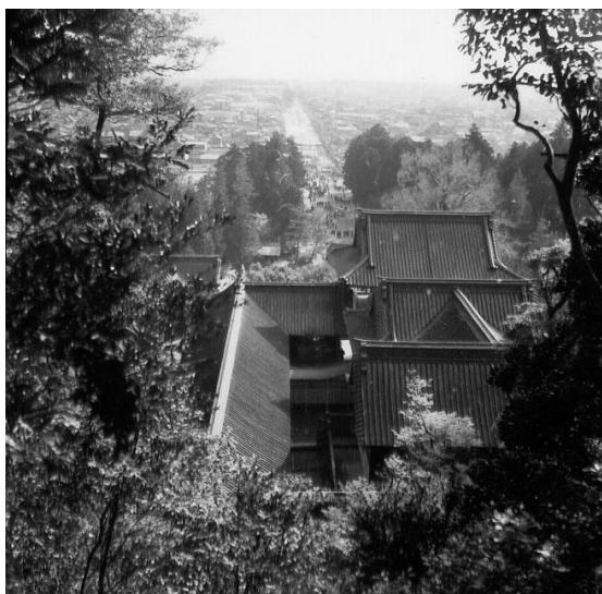
鶴岡八幡宮本殿 昭和28年秋撮影 大臣山から見た鶴岡八幡宮本殿の瓦葺き屋根のはるか向うに鎌倉の町が見える。文政年間に再建された建物は今、平成の大修理を終えたところである。
