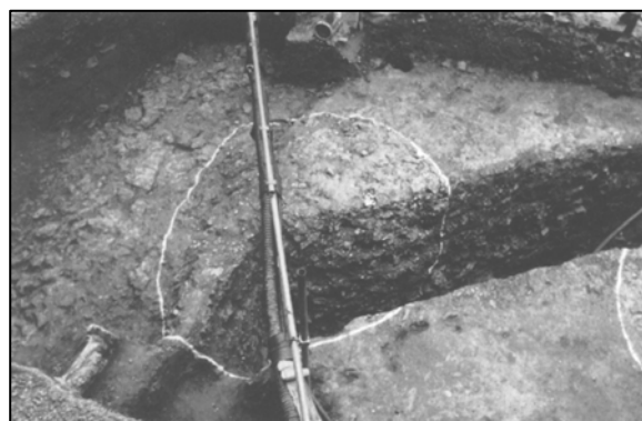
鎌倉大仏殿 礎石下の根固め遺構
